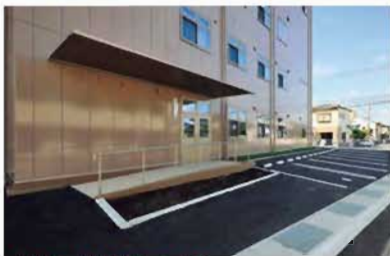
▲外部（北側スロープ）
