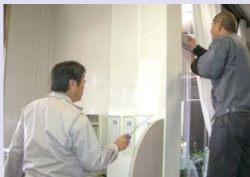
施設内の壁の塗り替え（外来受付前）
