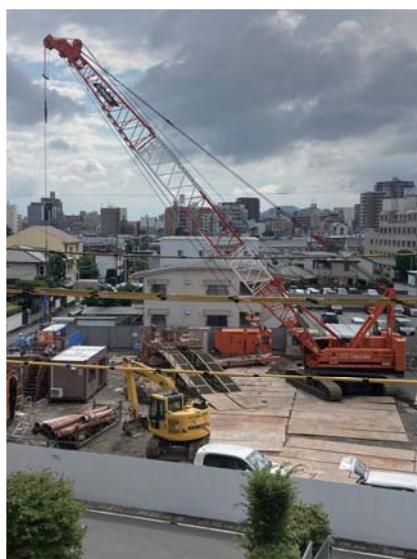
【基礎杭打ち工事の様子】
