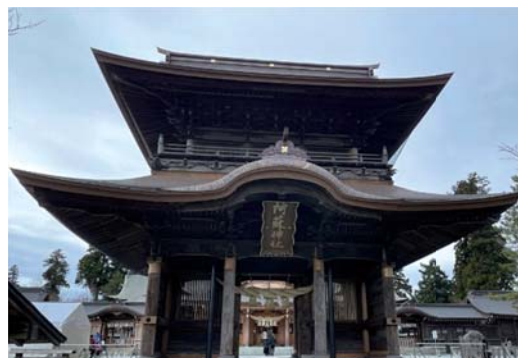
復旧された阿蘇神社楼門
